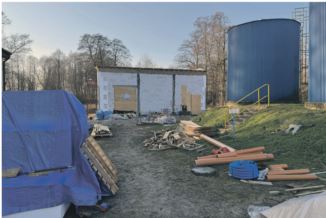
Stacja Uzdatniania Wody przejdzie kompleksową modernizację
